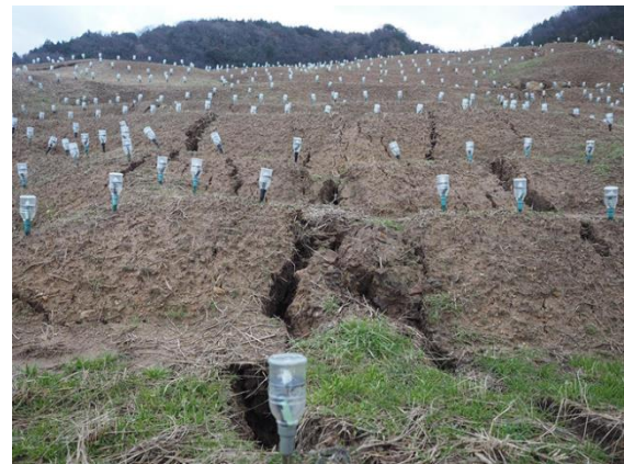
Fig.1 地震直後の棚田法面の亀裂被災
