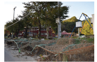
被災した校舎・グラウンド
